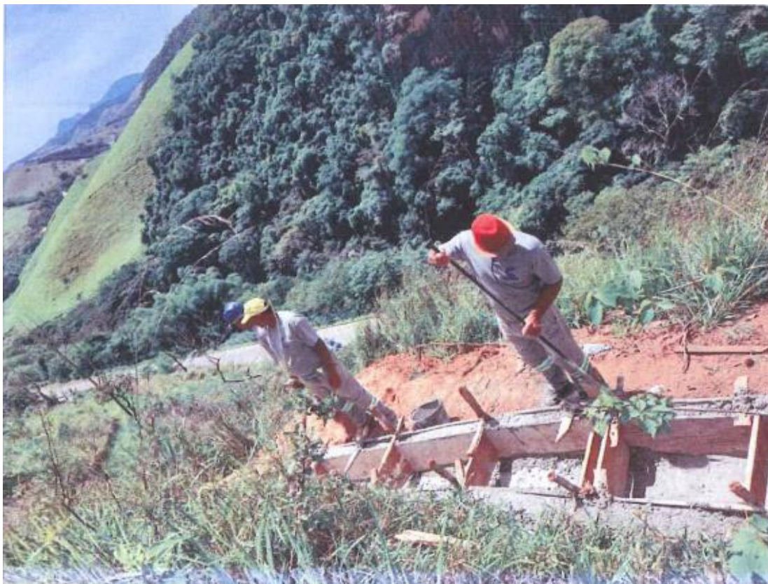
Foto 9 – Ampliação do sistema drenagem [1]
