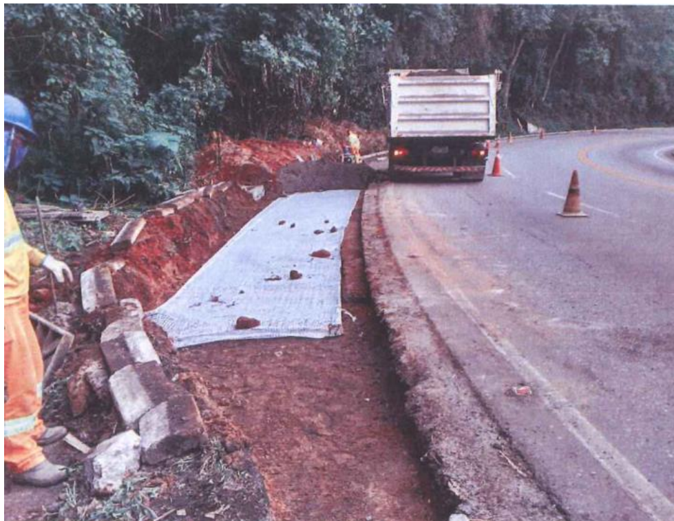
Foto 8 – Implantação de área de refúgio – Km 054+100 [2]
