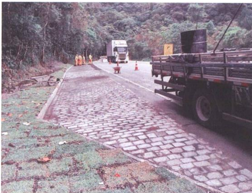
Foto 7 – Implantação de área de refúgio – Km 054+100 [1]
