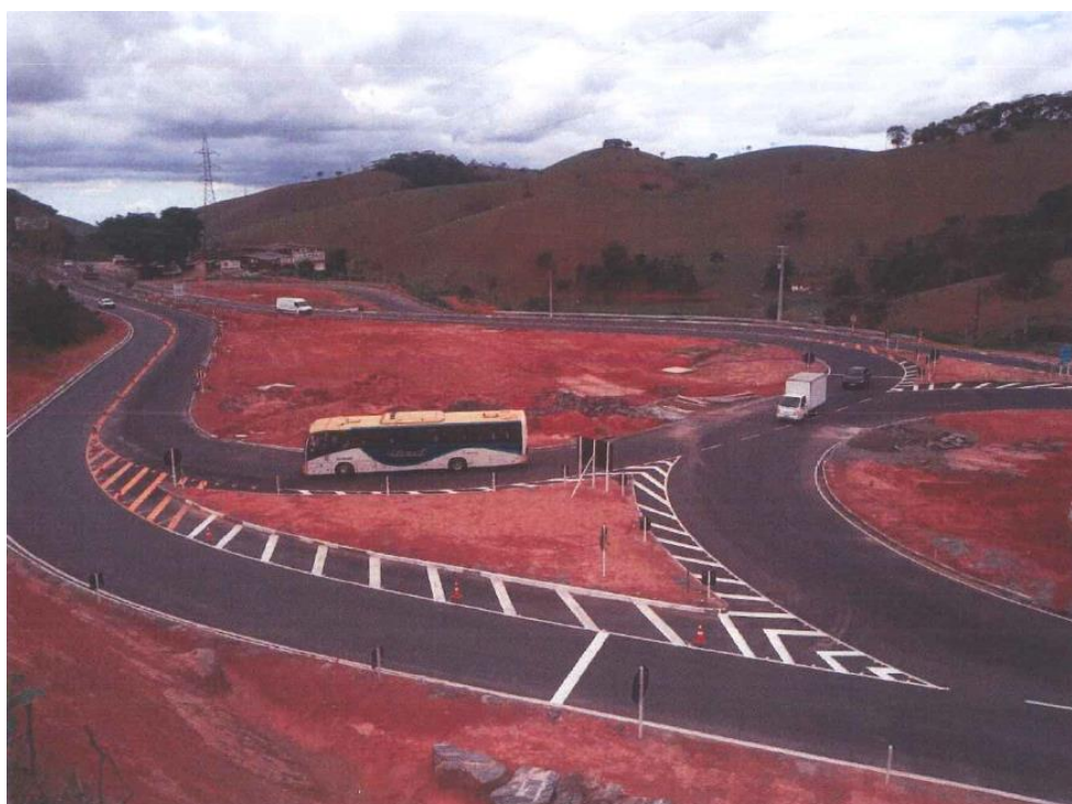
Foto 2 – Adequação da Interseção Cordeiro A – Km 123+300 [2]
