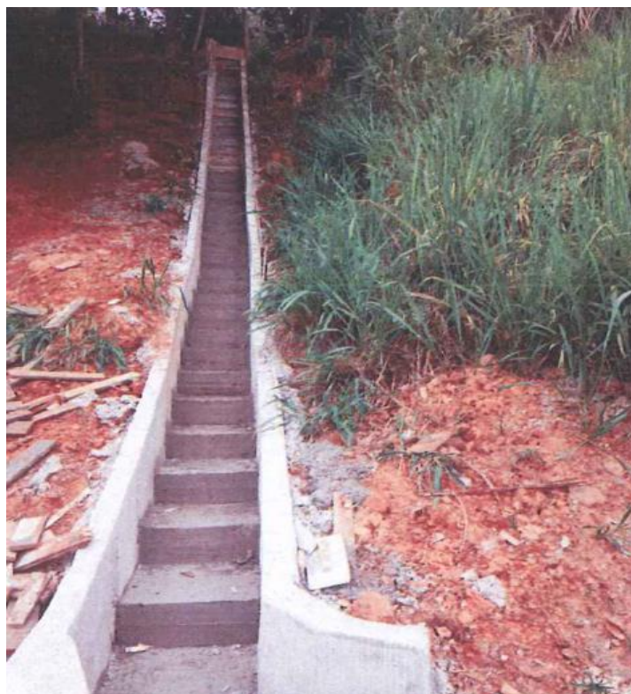
Foto 10 – Ampliação do sistema drenagem [2]
